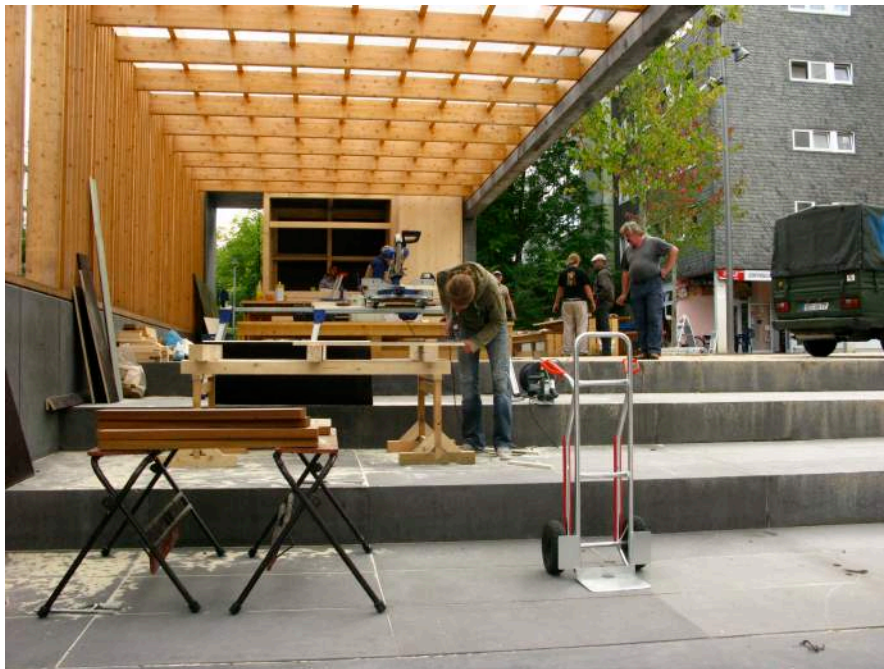
Bild 1: Paviljongen i Hustadt under konstruktion. Bilden kommer från projektets blogg. 30
